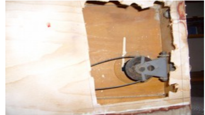
Umlenkrolle ausgebaut u.lackiert
