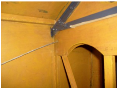
Konservierung d. Holzteile
