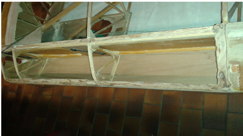
Die Nasenbeplankung wird weitgehend erneuert.
