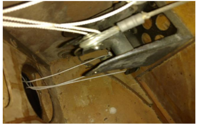
Klappenbeschlag gereinigt und lackiert
